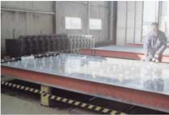
Bild 8. Einbau der Querbewehrung in Elementplatten Fig. 8. Installation of transverse reinforcement in the precast slabs
