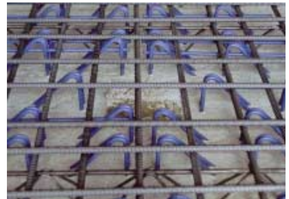
Bild 4. Obere Biegezugbewehrung auf den Obergurten der Filigran-Durchstanzbewehrung Fig. 4. Upper flexural reinforcement on the upper chords of the Filigran punching shear reinforcement
