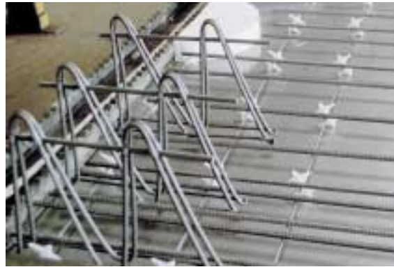
Bild 9. Die Filigran-Durchstanzbewehrung wird auf die Querstäbe gestellt Fig. 9. The Filigran punching shear reinforcement is placed on the transverse bars
