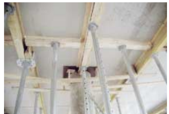
Bild 13. Abschalung von Druckfugen Fig. 13. The formwork for the compression joints is installed
