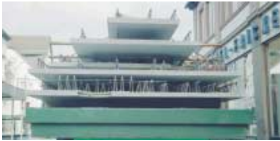
Bild 11. Transport von Elementdecken Fig. 11. Precast slabs in transport
